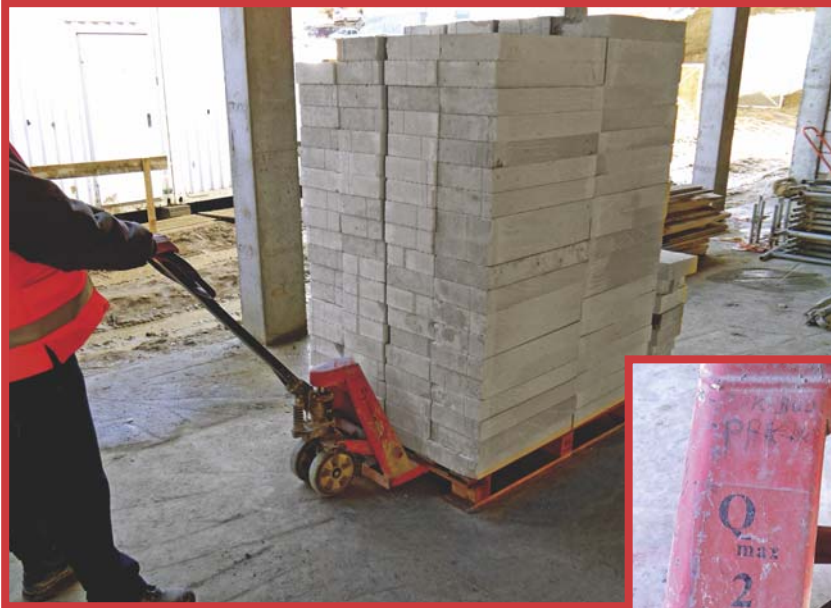
Nadmierna ilość luzem ułożonych bloczków betonowych i nieczytelne oznakowanie dopuszczalnego udźwigu.
