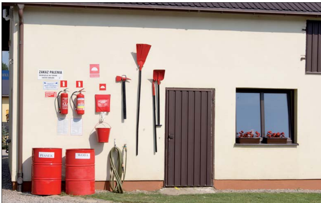
Fot. 20. W każdym gospodarstwie rolnym powinien znajdować się łatwo dostępny zewnętrzny punkt przeciwpożarowy wyposażony w: drabinę, bosak, siekiere, łopaty, tłumice, wiadra, gaśnice, pojemniki z wodą i z piaskiem. Sprzęt ten należy trzymać pod zadaszeniem, a piasek i wodę należy chronić przed zanieczyszczeniem i zamrożeniem.
