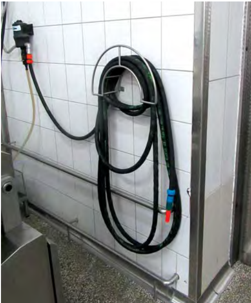
Fot. 9. Wąż wodny zawieszony na zwijaczu wraz z końcówką samozamykającą.
