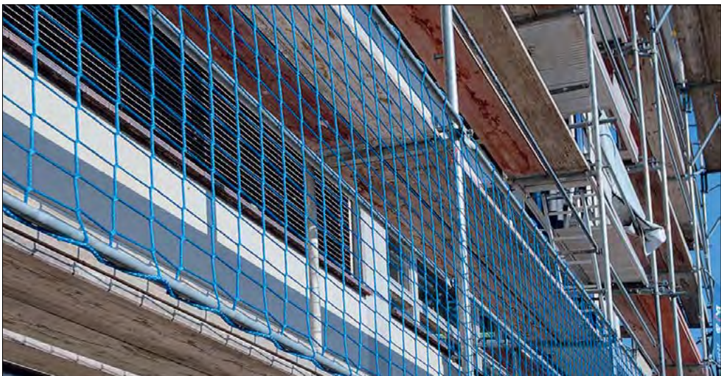
Fot. 8 Zabezpieczenie typu U
