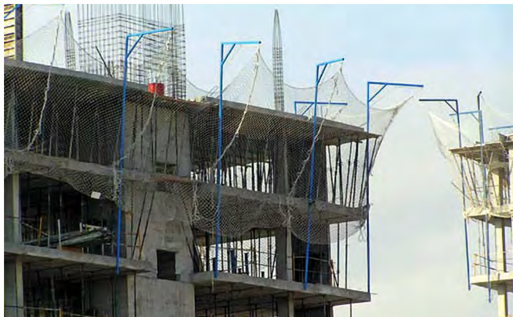
Fot. 10 Zabezpieczenie typu V
