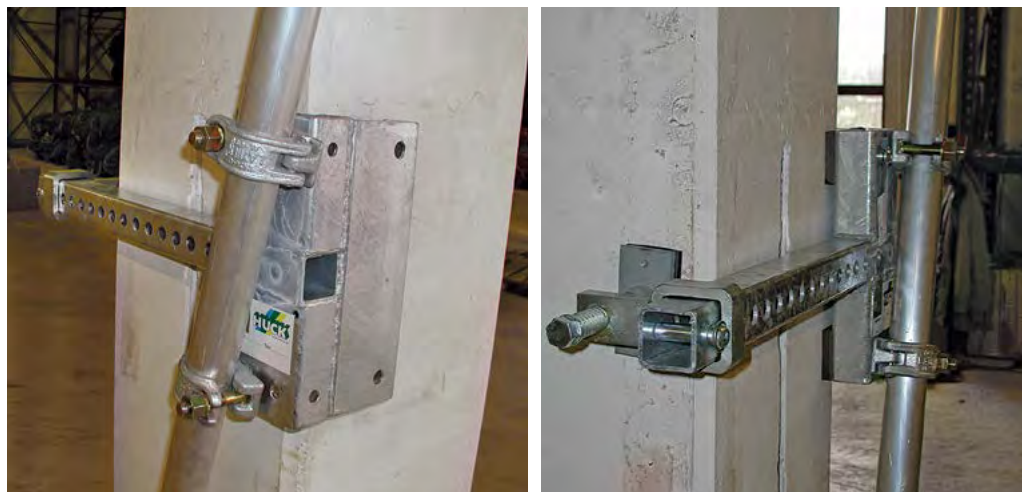
Fot. 24 i 25 Mocowanie zaciskowe
