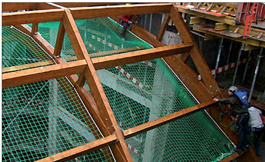
Fot. 5 Zabezpieczenie dachu
