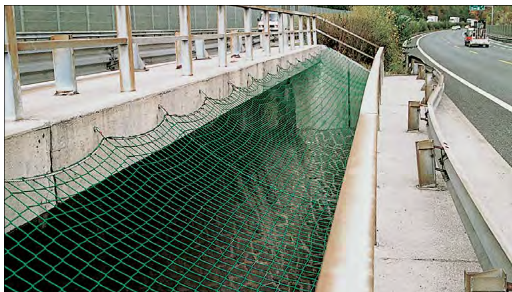
Fot. 6 Zabezpieczenie wiaduktu na autostradzie
