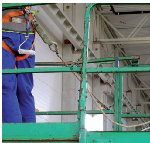
Przykłady stosowania ŚOI i fabrycznych punktów kotwiczenia.
