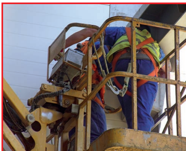
Zamocowanie uprząży linką w sposób niezgodny z instrukcją producenta.
