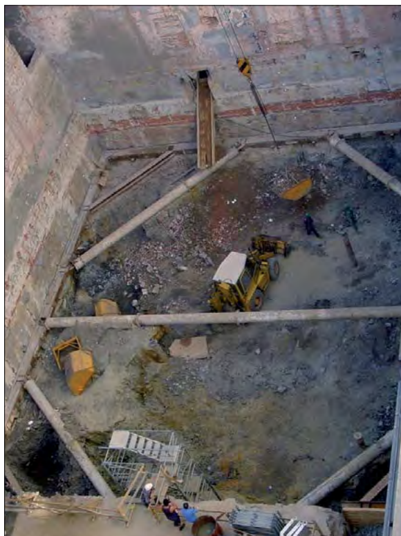
Fot. 24 i 25. Przykłady wykopów zabezpieczonych przy pomocy palisady z kolumn jet-grouting.
