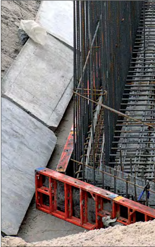
Fot. 15. Zabezpieczenie skarpy w poziomie posadowienia obiektu, płytami drogowymi typu „MON”. Płyty ułożono w celu ustabilizowania skarpy w miejscu, gdzie występuje największe ryzyko obsunięcia.
