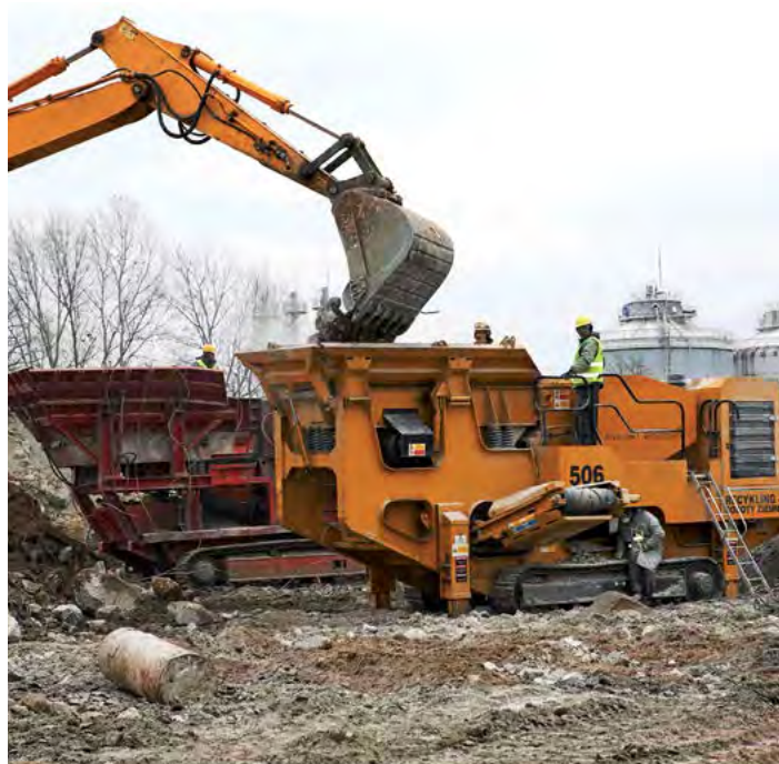
Fot. 4. Roboty przygotowawcze, polegające na usunięciu i utylizacji zbędnych elementów i budowli z terenu nowej inwestycji.
