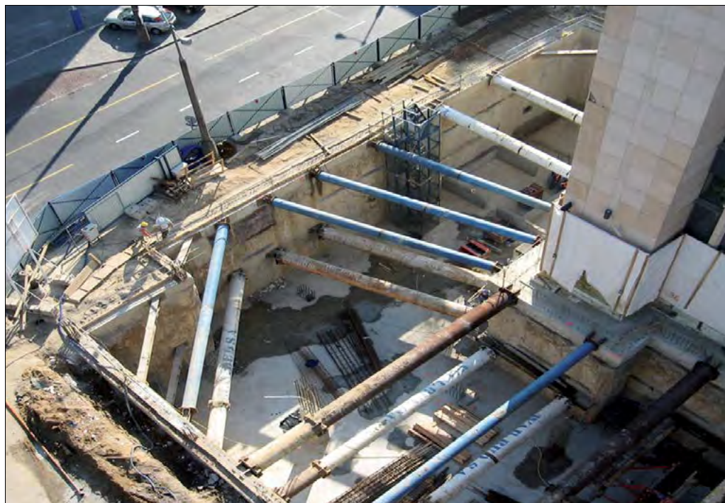
Fot. 26. Rozparcie ścian szczelinowych w narożniku wykopu w sąsiedztwie istniejącego budynku.
