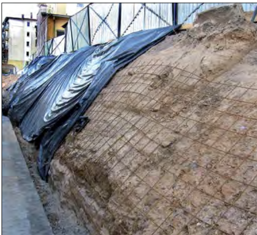
Fot. 16. Etapy wykonania zabezpieczenia skarpy poprzez ułożenie zbrojenia i w następnej kolejności mieszanki betonowej, zabezpieczona geotekstyliami.
