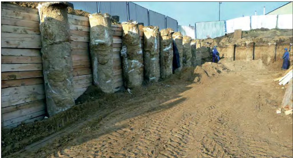
Fot. 21. Zabezpieczenie wykopu wykonane ścianką berlińską, gdzie elementem konstrukcyjnym są pale CFA. Ze względu na większą sztywność kolumn zabezpieczenie nie wymaga dodatkowego usztywnienia rozporami.
