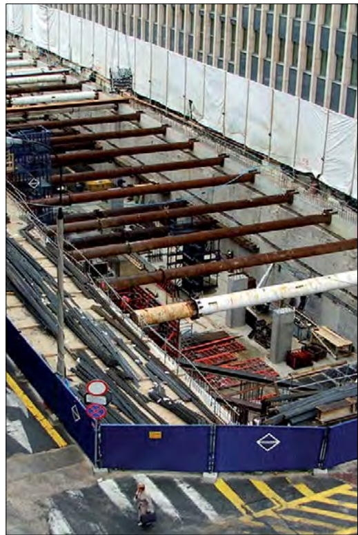
Fot. 28. Zabezpieczenia głębszych wykopów.
