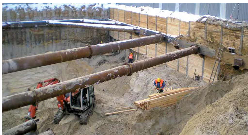
Fot. 20. Zabezpieczenie wykopu wykonane ścianką berlińską. Zastosowano kształtowniki stalowe oraz dodatkowo rozparto rurami stalowymi wspartymi na oczepach.
