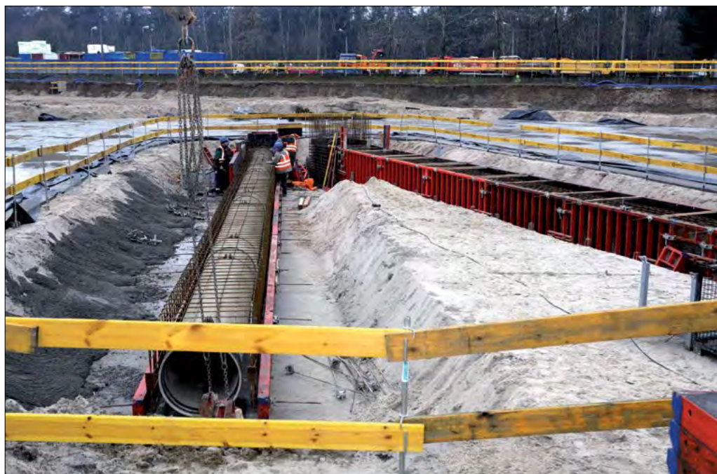
Fot. 10. Wykop o głębokości do 1,25 m.
