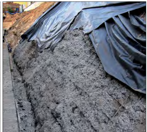
Fot. 17. Dodatkowym zabezpieczeniem przed rozmyciem skarpy i masy betonowej jest folia. Stosuje się ją do czasu utwardzenia się betonu.
