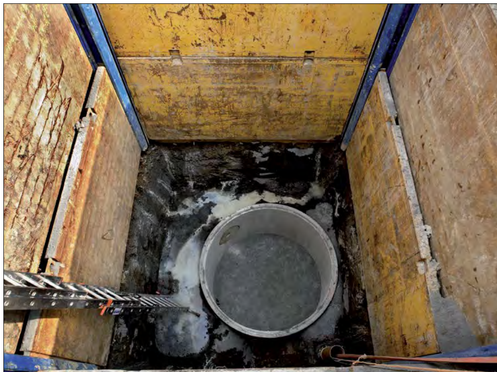
Fot. 29. Zabezpieczenie wykopu poprzez zastosowanie systemowego rozwiązania, na które składają się panele i belki.
