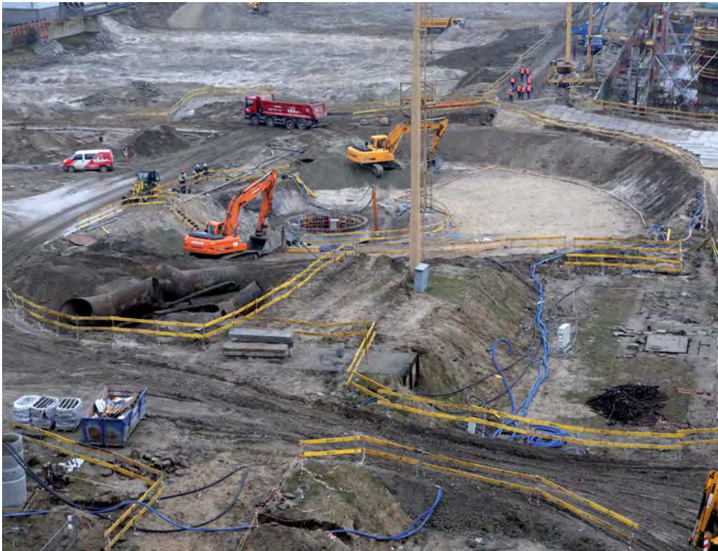
Fot. 2. Plac budowy oczyszczalni ścieków „Czajka” w Warszawie. Roboty budowlane, w tym ziemne, prowadzone były na placu budowy o powierzchni 50 ha.
