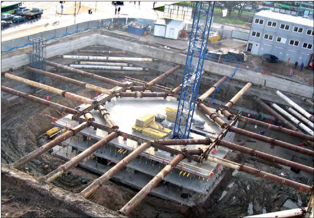
Fot. 27. Rozparcie ścian szczelinowych w narożniku wykopu w sąsiedztwie istniejącego budynku.
