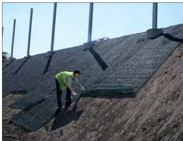
Fot. 13 i 14. Wyprofilowana skarpa zabezpieczona geotekstyliami.
