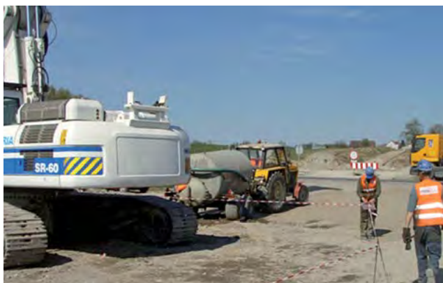
Fot. 8. Wydzielenie i oznakowanie strefy niebezpiecznej pracy maszyny.
