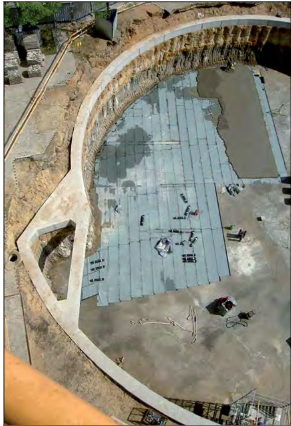
Fot. 22. Zdjęcie przedstawia palisadę z kolumn DSM usztywnioną oczepem żelbetowym.
