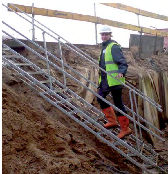
Fot. 6 i 7. Schody stanowiące drogę komunikacyjną do i z wykopu.
