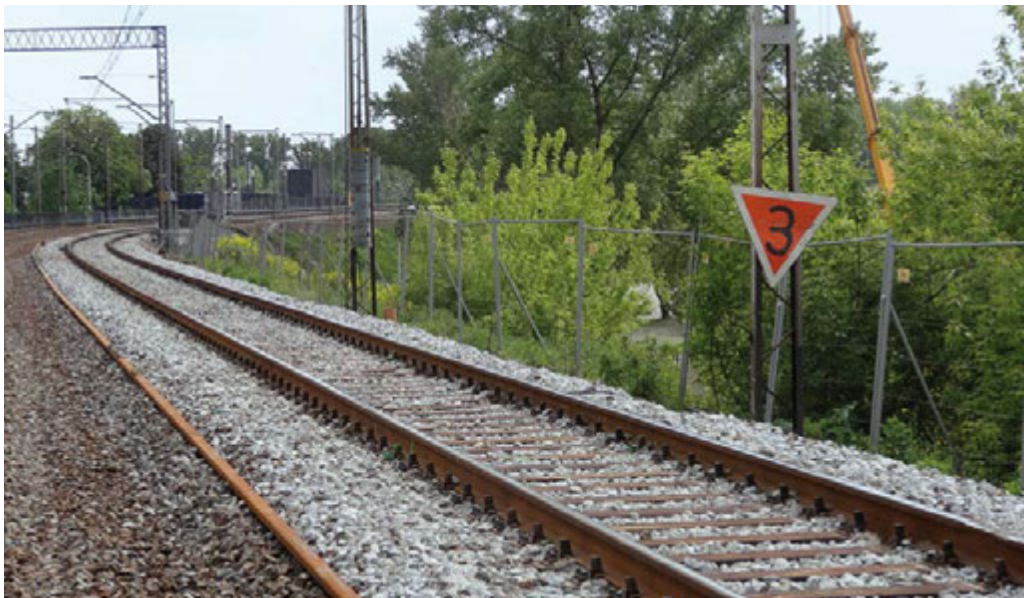
Fot. 24. Tarcza D6, informująca o konieczności zwolnienia biegu pociągu do 30 km/h
