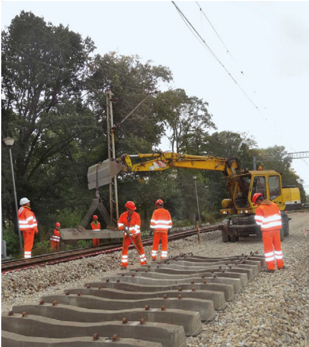
Fot. 36. Układanie podkładów za pomocą maszyny dwudrogowej
