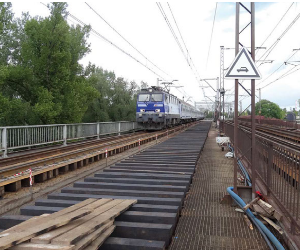
Fot. 6. Linia kolejowa, na której obowiązuje ograniczenie prędkości pociągów poniżej 100 km/h
