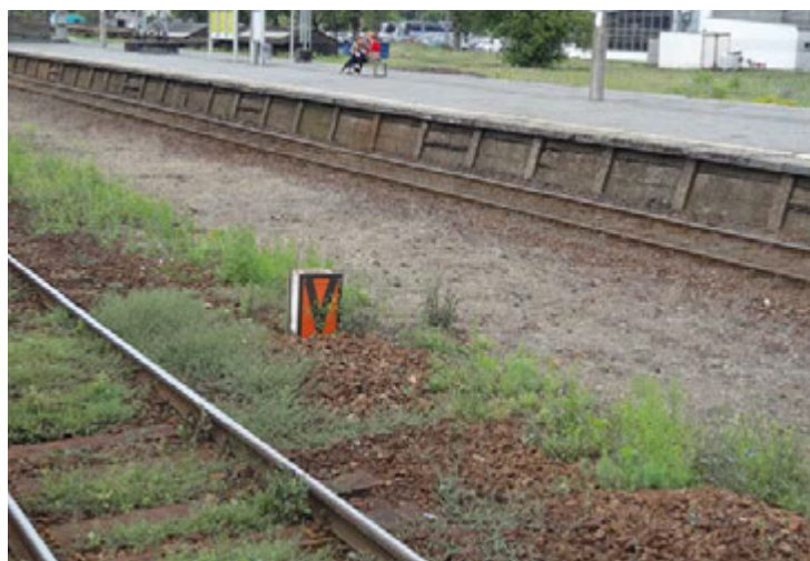
Fot. 25. Początek odcinka ograniczenia prędkości pociągu
