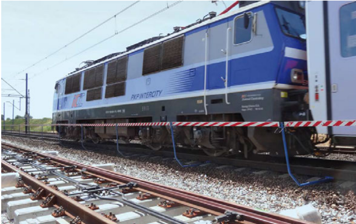
Fot. 17. Przejazd pociągu osobowego z prędkością 100 km/h za wygradzeniem miejsca prac stałymi barierami
