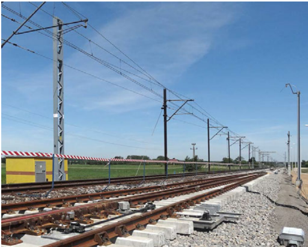
Fot. 27. Sieć trakcyjna na linii nr 4 Grodzisk Mazowiecki – Zawiercie – Centralna Magistrała Kolejowa
