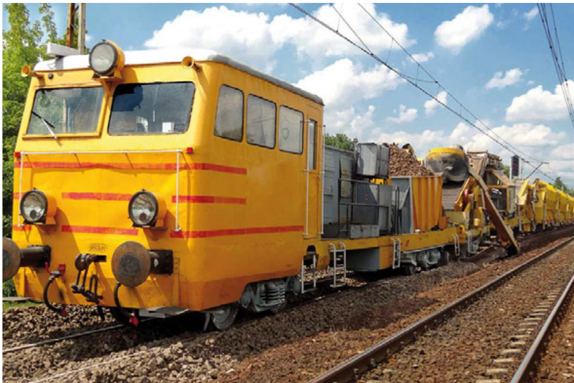
Fot. 34. Oczyszczarka torów
