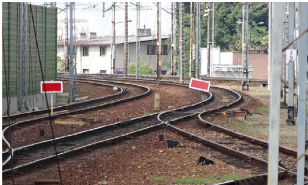
Fot. 14. Sygnał D1 „Stój” dawany tarczą zatrzymania na terenie stacji Warszawa Wschodnia Osobowa. Prostokątna czerwona tarcza z białą obwódką
