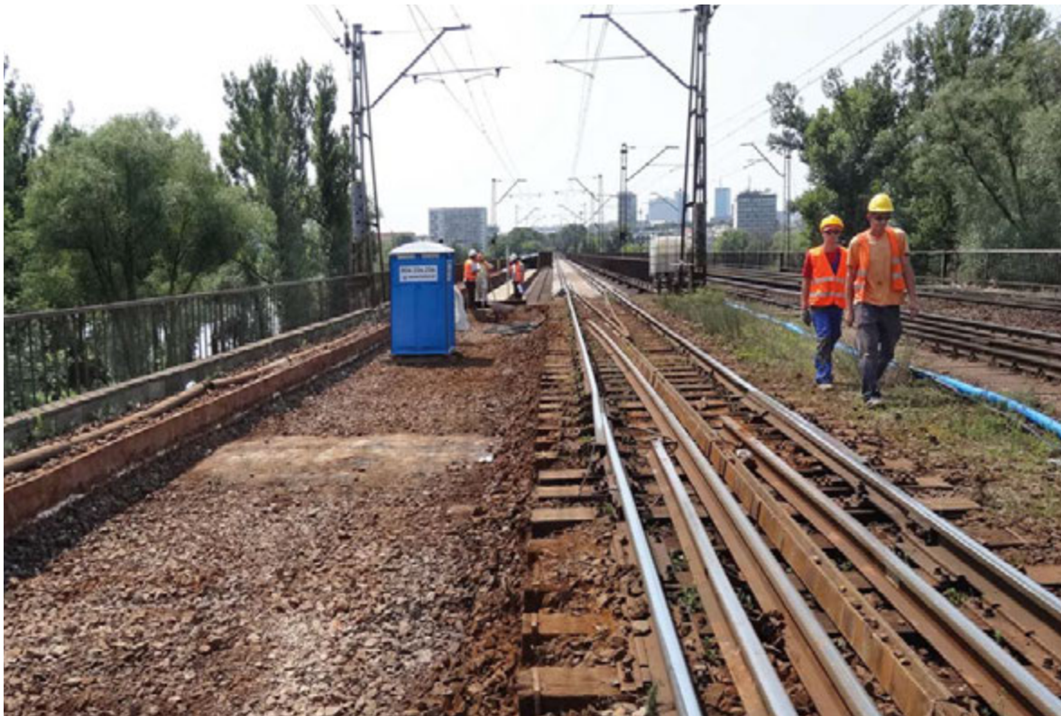
Fot. 5. Pracownicy, idący międzytorzem do miejsca robót
