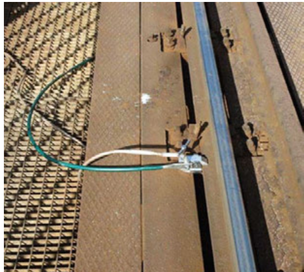
Fot. 29. Zacisk uszynienia, przenośnego uszyniacza ochronnego, przykręcony do szyny
