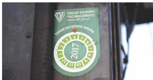
Fot. 4. Urządzenia ciśnieniowe podlegają okresowym badaniom technicznym.
