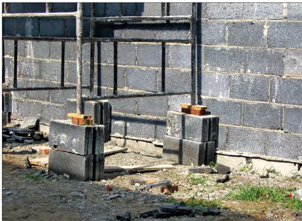
Niebezpieczny sposób posadowienia rusztowania.
