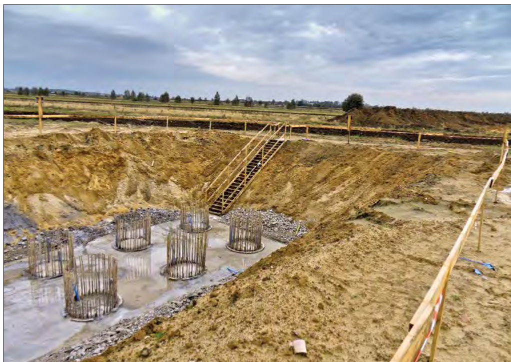
Zejście do wykopu po schodach.
