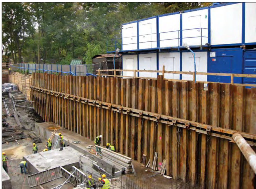
Ściany pionowe zabezpieczone obudową.
