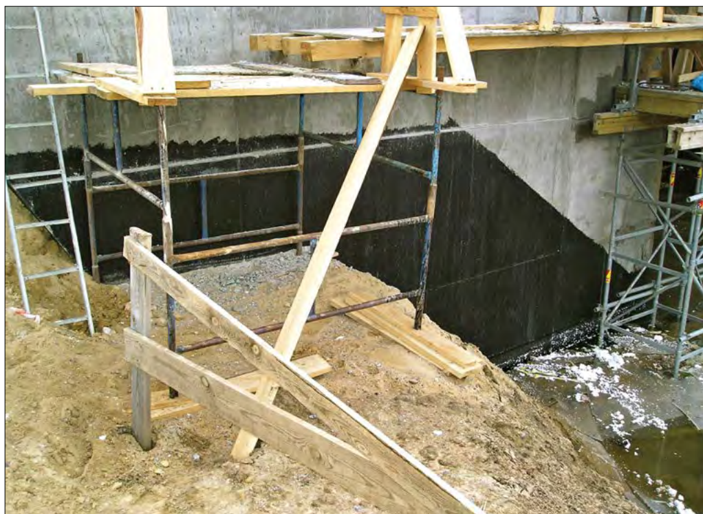
Niebezpieczny sposób posadowienia rusztowania.
