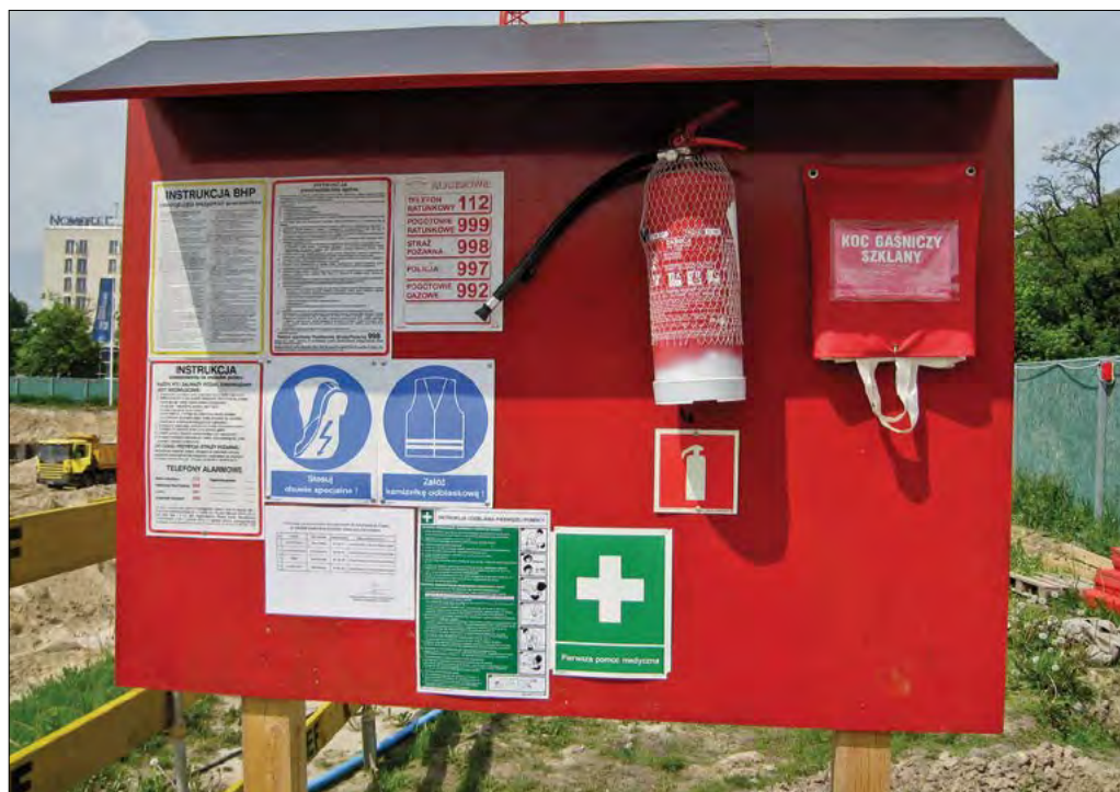
Punkt ppoż. na budowie.
