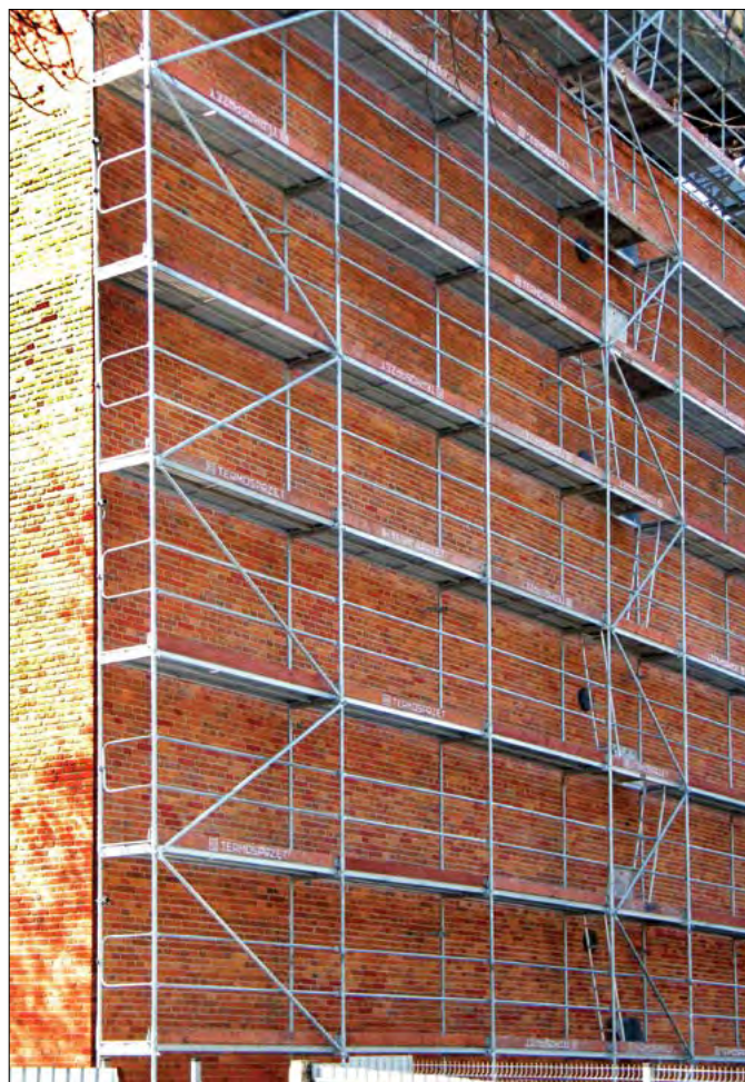
Bezpieczny montaż rusztowania systemowego.
