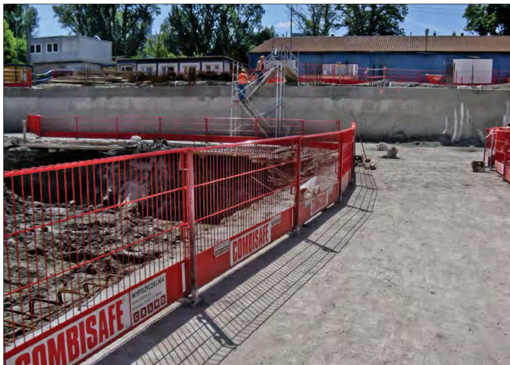
Wygodzenie zabezpiecza osoby, które poruszają się w sąsiedztwie wykopu.
