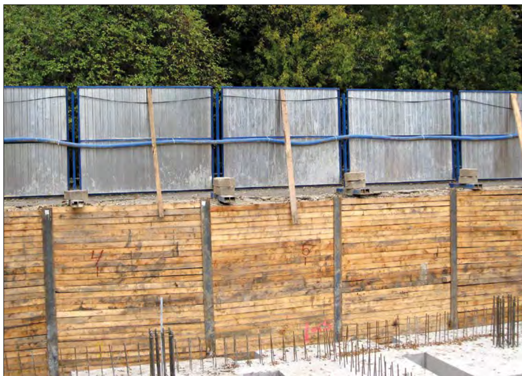
Ściany pionowe zabezpieczone obudową.
