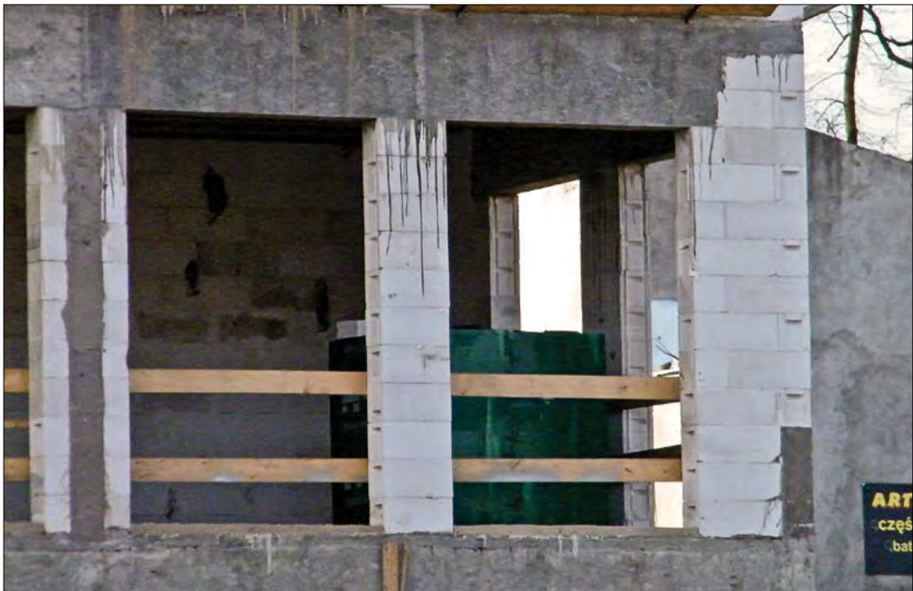
Balustrady mocowane od strony wewnętrznej otworu w ścianie.
