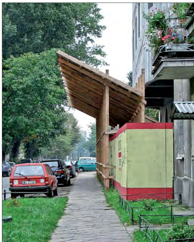
Daszki ochronne powinny znajdować się na wysokości nie mniejszej niż 2,4 m nad terenem w najniższym miejscu i być nachylone pod kątem 45^\circ w kierunku źródła zagrożenia.
