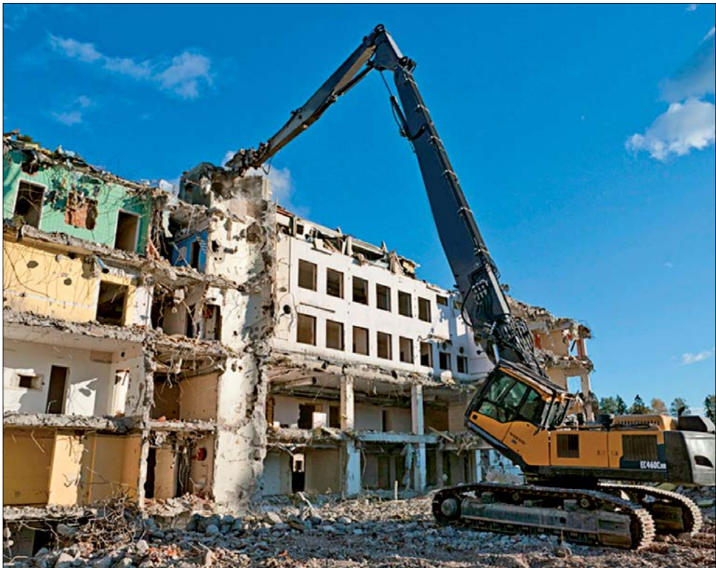
Rozbórka budynku murowanego za pomocą koparki.
