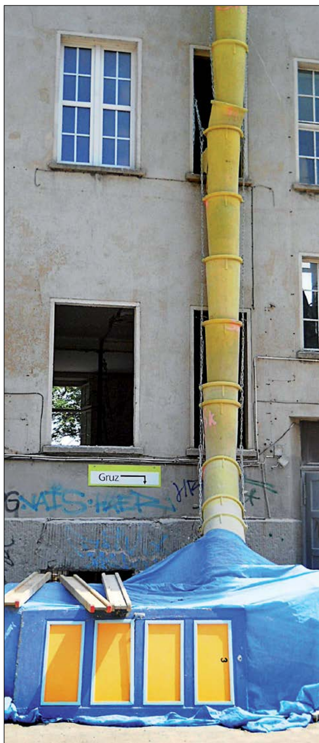
Rynna zsypowa do gruzu eliminuje ręczne znoszenie materiału z rozbiórki.
