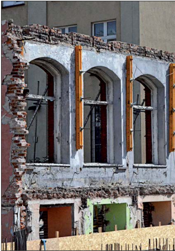
Sposoby zabezpieczenia starych ścian przed przewróceniem.
