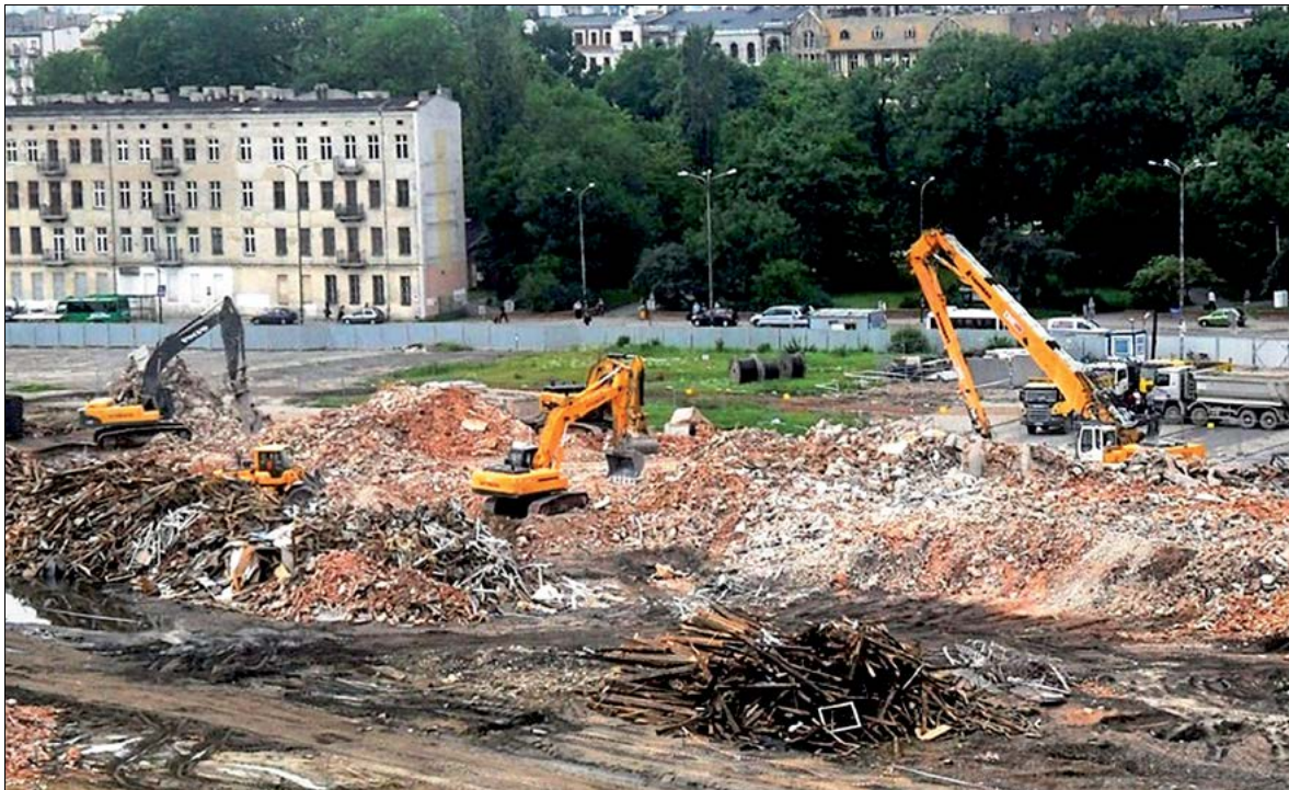
Maszyny i środki transportu podczas rozbiórki.
