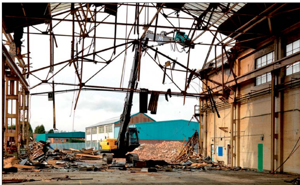
Rozbórka konstrukcji stalowej przez cięcie.
