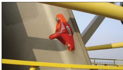
Fot. 26. Słupek dachowy mocowany do stropu kotwami.
