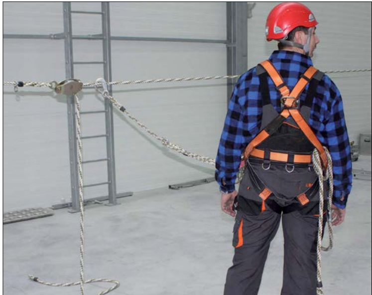
Fot. 32. Pracownik przypięty do systemu linowego z urządzeniem napinającym typu HARIP.
