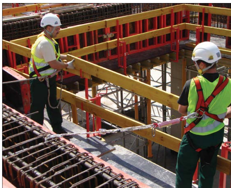
Fot. 2, 3. System szczękowy mocowania barierek.
