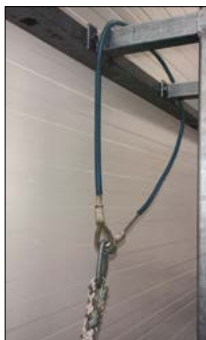
Fot. 30. Zaczep linkowy.
