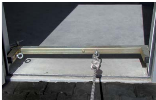
Fot. 31. Belki poprzeczne – rozpierane pomiędzy otworami.
