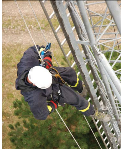
Fot. 13. Praca z użyciem technik linowych.
