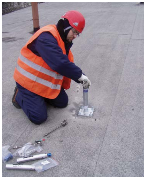
Fot. 26. Słupek dachowy mocowany do stropu kotwami.
