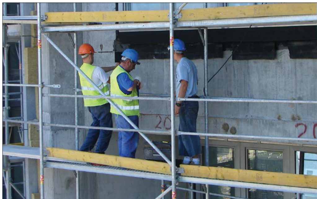
Fot. 1. Praca na balustradach.
