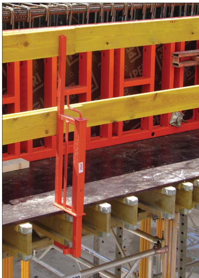
Fot. 2, 3. System szczękowy mocowania barierek.
