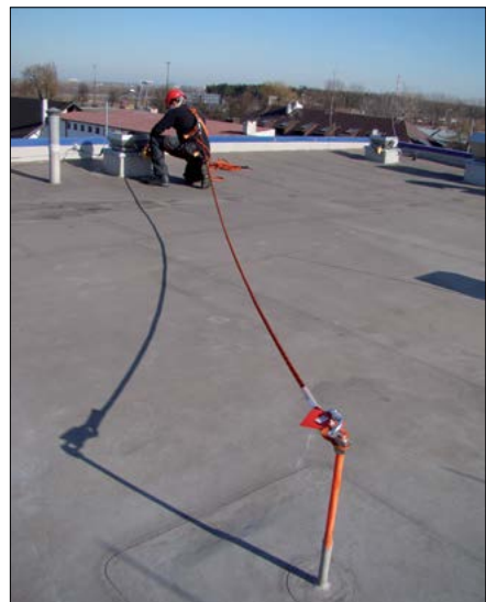
Fot. 25. Słupki dachowy mocowany do blachy trapezowej pod membraną.
