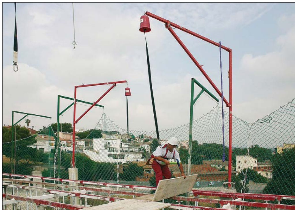
Fot. 34. Praca z systemem Alsipercha 7 Alsipercha – rozwiązanie specjalne.
