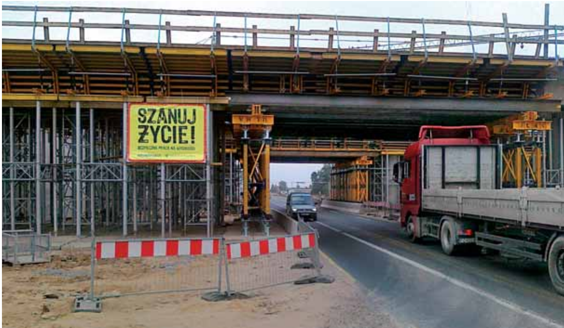
Zdjęcie 3: Plac budowy; w tle banner „Szczuj życie”
