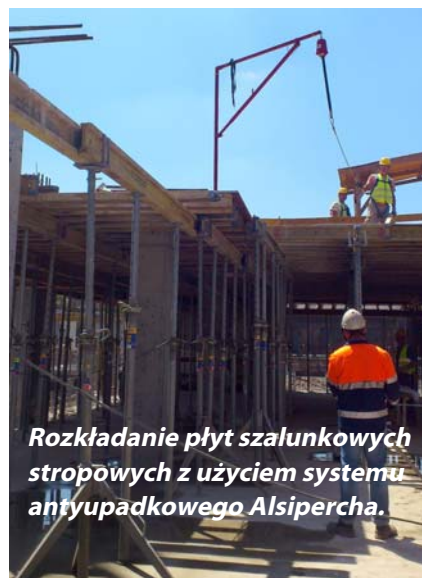
„Szubienica” Alsipercha przygotowana jako część składowa systemu zabezpieczającego pracowników podczas rozładunku materiałów z samochodu ciężarowego.
