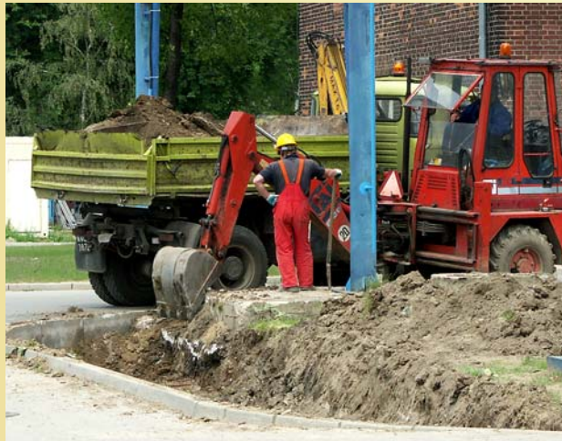
Miejsce robót ziemnych należy ogrodzić i oznakować
