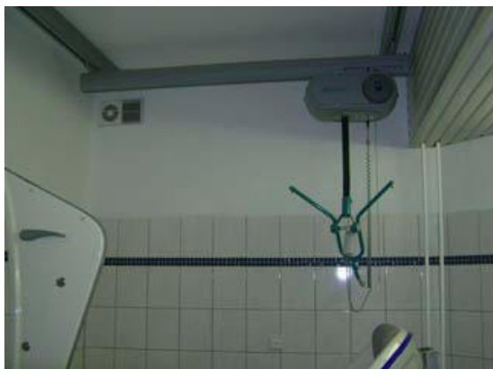
Podnośniki na prowadnicach podsufitowych
