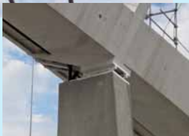
Rozerwane elementy łączące tzw. krokodyle.
