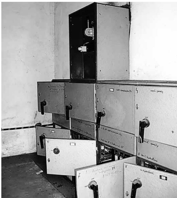
2. Rozdzielnica niskiego napięcia – pełniąca funkcję stacji oddziałowej SP, zgodnie ze schematem zamieszczonym na rys. 1.
