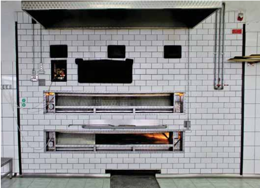
Fot. 4. Piec piekarski wyposażony w wentylację miejscową.
