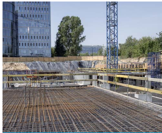
Stropy przed betonowaniem należy zabezpieczyć.
