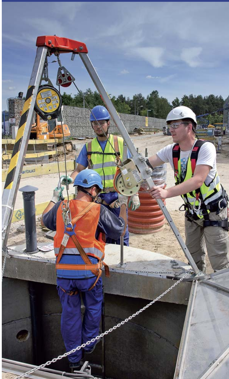
Urządzenie umożliwiające ewakuację nieprzytomnego pracownika.
