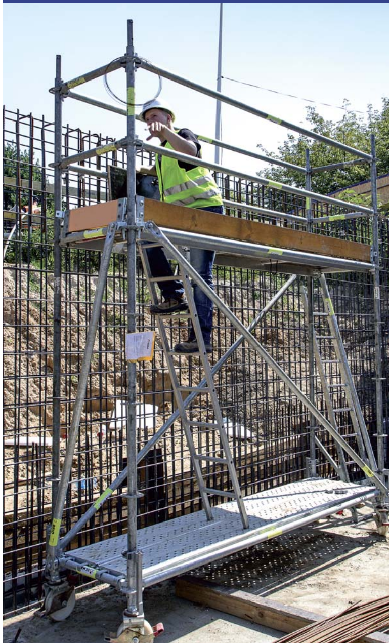
Hamulec rusztowania przejezdnego.
